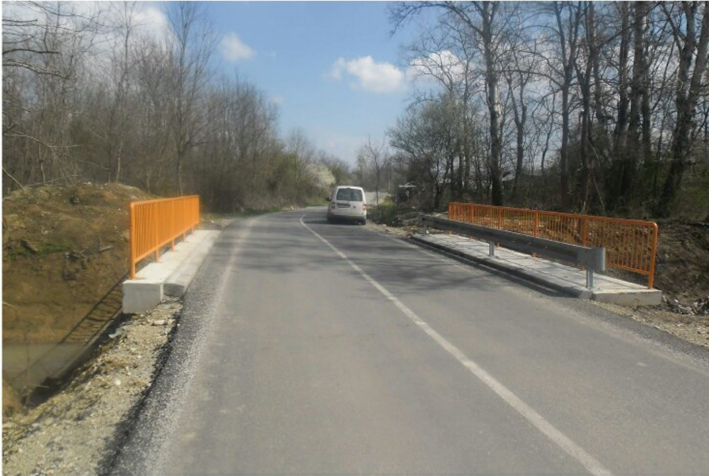
Слика 8. Мост на путу ка Великом Поповићу
